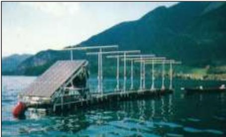
Montiert werden die Galgen auf Schwimmstegen und am besten etwas vom Ufer entfernt, verankert. Für den Anschluss an einen Stromkreis, ist ein (12 Volt) Transformator verfügbar um das Risiko elektrischer Unfälle bei hohen Voltzahlen zu verhindern. Für die autonome Funktion in abgelegenen Gebieten wird ein effizienter Solargenerator geliefert.
