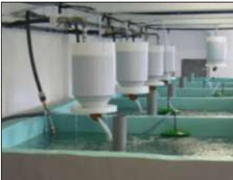
Diese Module sind ab einer Produktionskapazität von 10-50 t/Jahr (Fischbestand 2-10 t) erhältlich. Die Entfernung der Feststoffe aus dem Abwasser erfolgt durch Trommelfilter. Danach wird das Wasser in den Biofilter gepumpt, dort erfolgen die Umwandlung von Ammonium zu Nitrat und die Anreicherung mit Sauerstoff. Von dort gelangt das Wasser wieder in die Fischbecken, die zahlen-, größen- und formmäßig den Kundenanforderungen angepasst werden können.
